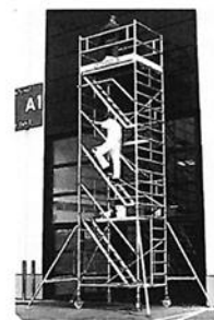
Scaffold erection การก่อสร้างนั่งร้าน
